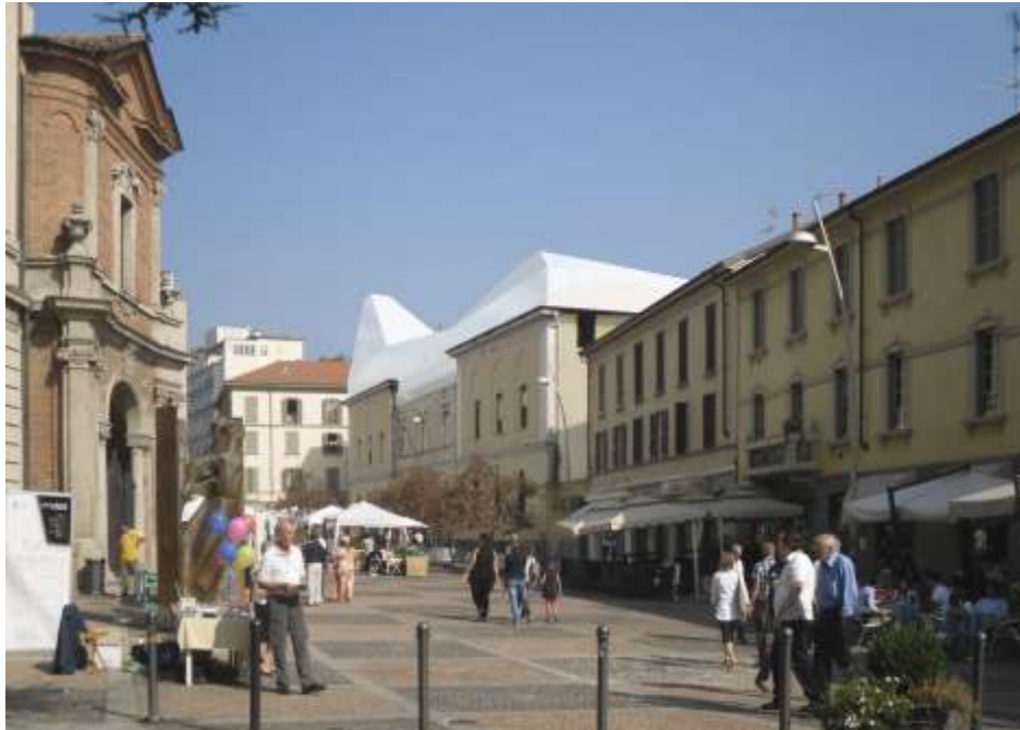
recupero caserma san paolo biblioteca centrale di monza
